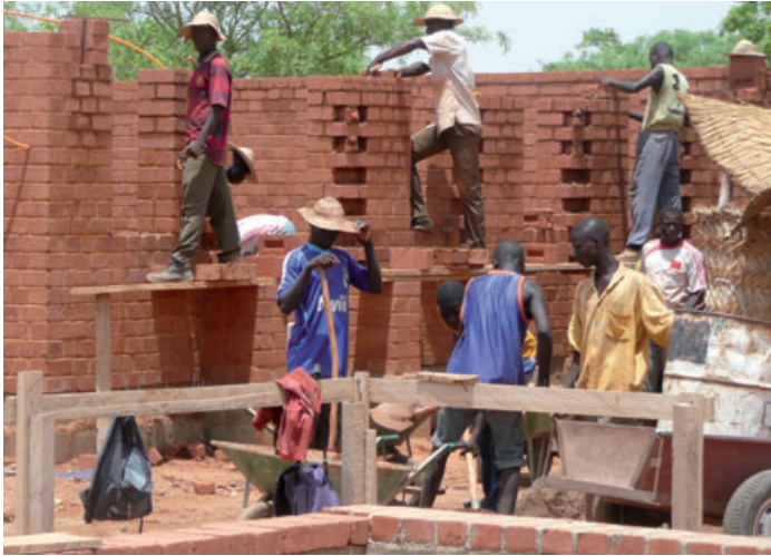
Bauarbeiten am Schulgebäude
